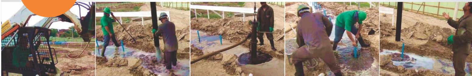
A Itubombas desenvolveu um sistema de cravação/instalação mecânica de ponteiros. Com a ajuda de uma máquina BobCat, as ponteiros são instaladas através de um processo de encamisamento, o que garante maior eficiência e agilidade a operação, tornando a qualidade do dreno vertical superior. Utilizando este processo é possível instalar 30/50 ponteiros dia.
